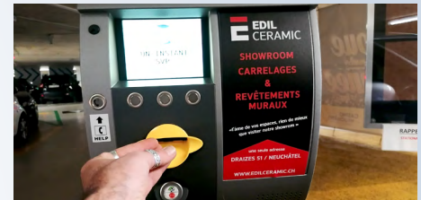
3 - Bornes de tickets d'entrée et de sortie : autocollants
